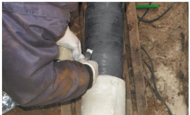
4. Концы ленты PSI Pipecast обернуть при помощи клейкой ленты, чтобы плотно прижать концы к трубе.
