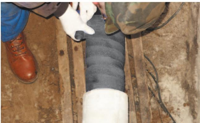
3. Оберните ленту PSI Pipecast после пропитывания в воде с нахлестом минимум 75% (таким образом, получается 4 слоя)
