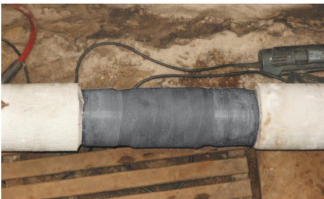
5. Отверждение PSI Pipecast происходит при температуре 23°C примерно через 20-30 минут, готов к протягиванию уже примерно через час
